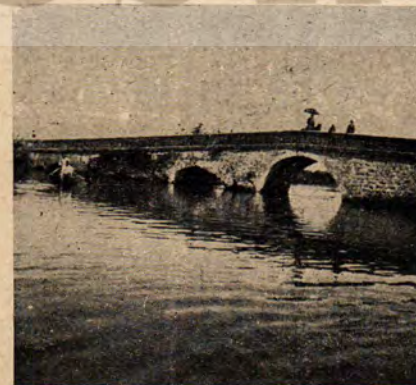
Temizlenen Düden Köprüsü
