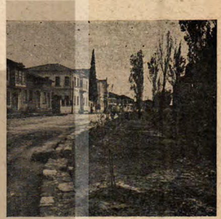
Temizlenen bir sur hendeği
